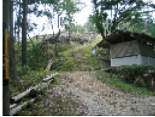
(町道より見上げる)
